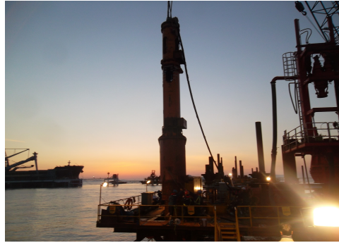
[ 그림 74 ] 저소음·저진동 공법 예시(파일 항타시 해머캡 사용)
