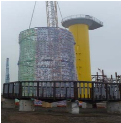
[ 그림 43 ] 수중소음 저감방안(수중소음 댐퍼) 예시
