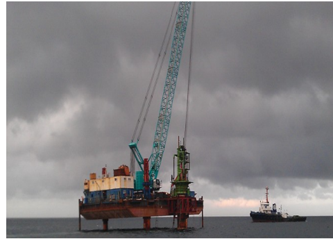
[ 그림 75 ] 저소음·저진동 공법 (R.C.D 장비 및 천공작업)
