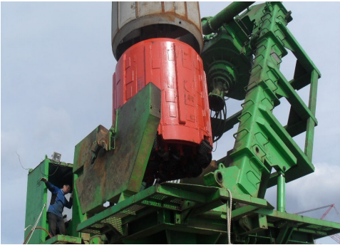
[ 그림 75 ] 저소음·저진동 공법 (R.C.D 장비 및 천공작업)
