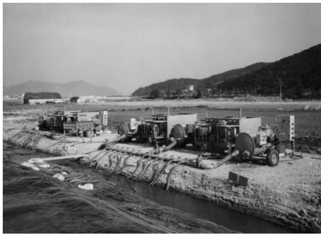
참고 그림 (7-42) 펌프를 이용한 진공압밀
