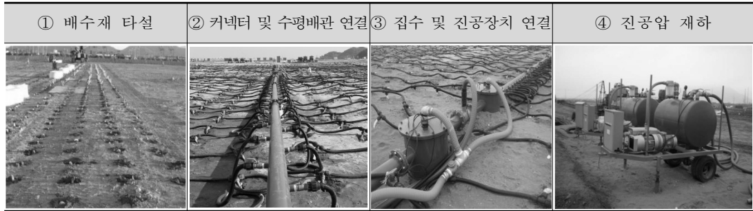
참고 그림 (7-48) 개별진공압밀공법 시공순서
